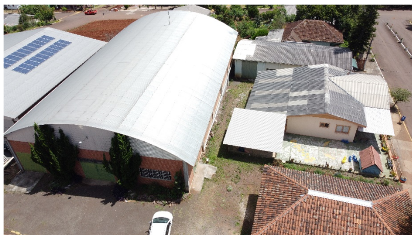
Figura 1 – Local da instalação.
