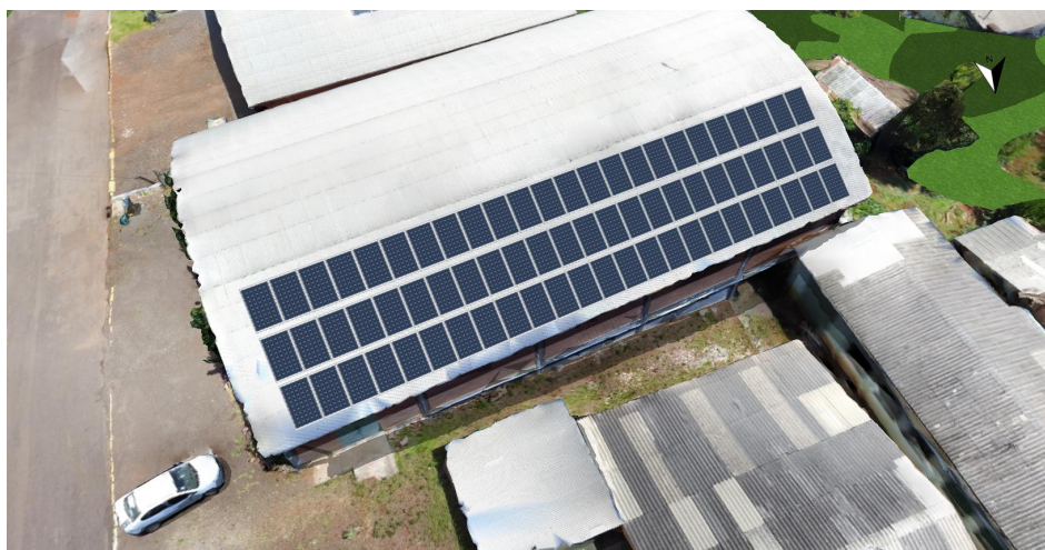
Figura 2 – Distribuição dos módulos no telhado. (155,4 m 2 )
