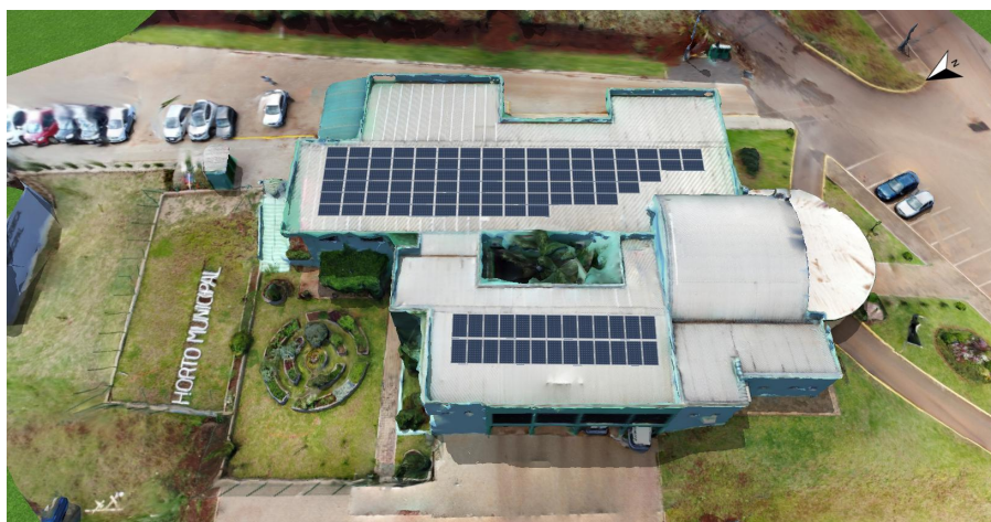
Figura 2 – Distribuição dos módulos no telhado. (241,7 m 2 )
