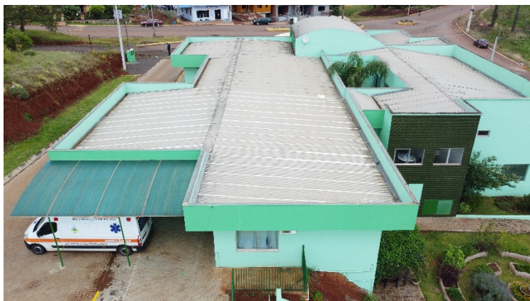
Figura 1 – Local da instalação.
