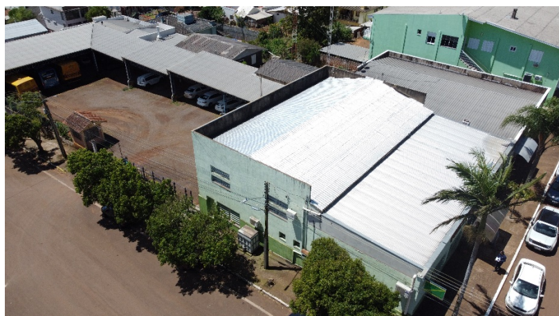
Figura 1 – Local da instalação.
