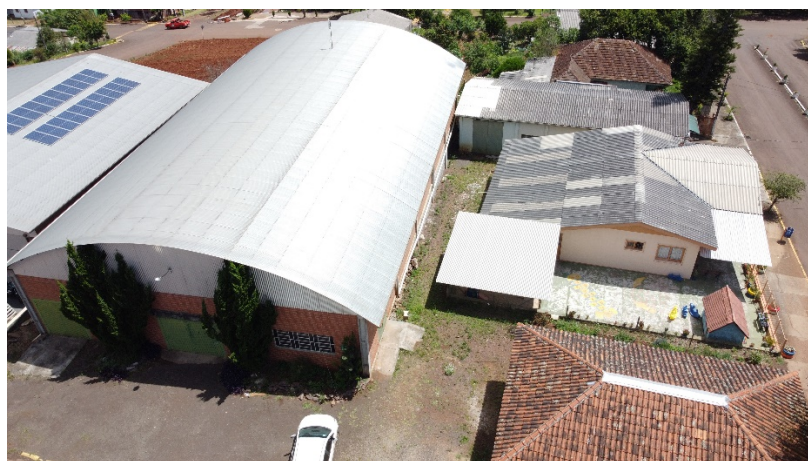
Figura 1 – Local da instalação.
